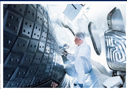
Messanschlüsse am Behälter Wendelstein 7-X
